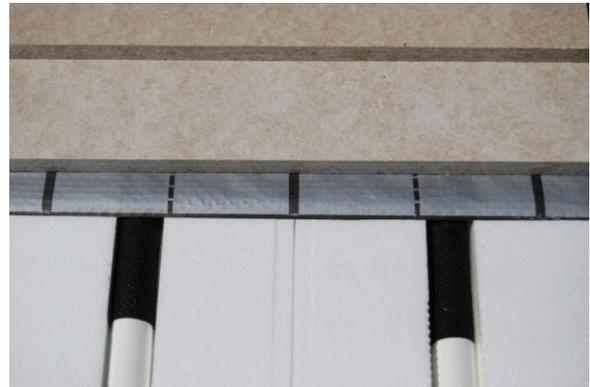
Das Bild zeigt eine Möglichkeit der Reduzierung der Wärmeabgabe bei einer Flächenheizung der Bauart B mit Dämmbändern.
